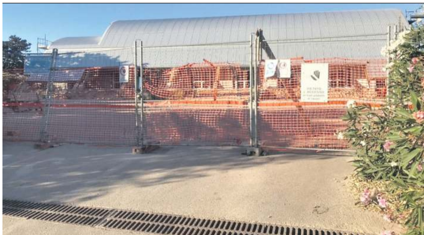
Il cantiere delle piscine di Maria Pia
