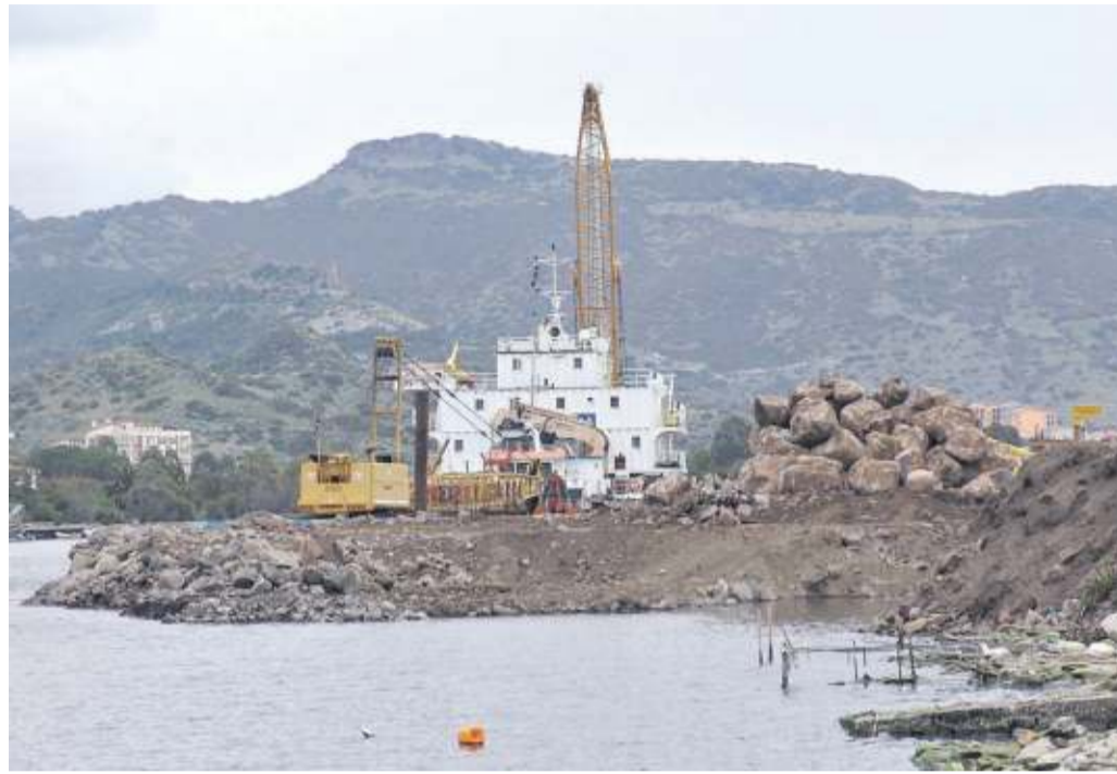
Una foto del 2011 con i lavori ancora in corso a Capu d'Aspu
