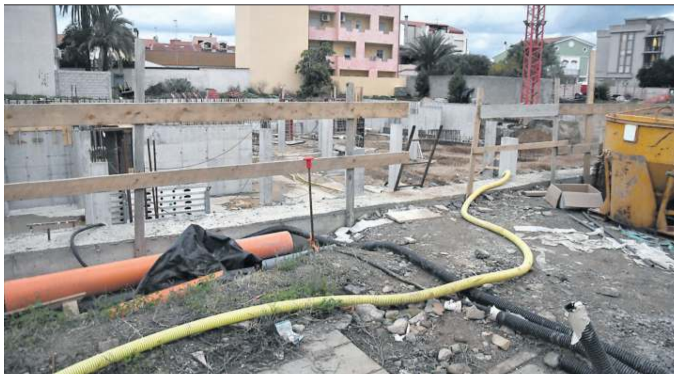
Uno scorcio del cantiere di via Lepanto
