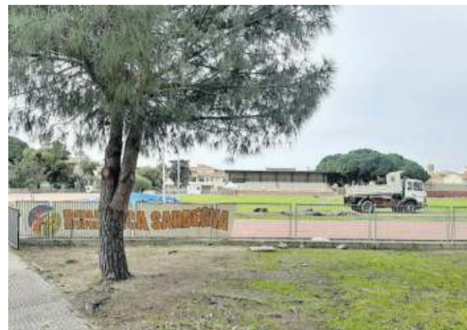
Il cantiere al campo sportivo ieri mattina
